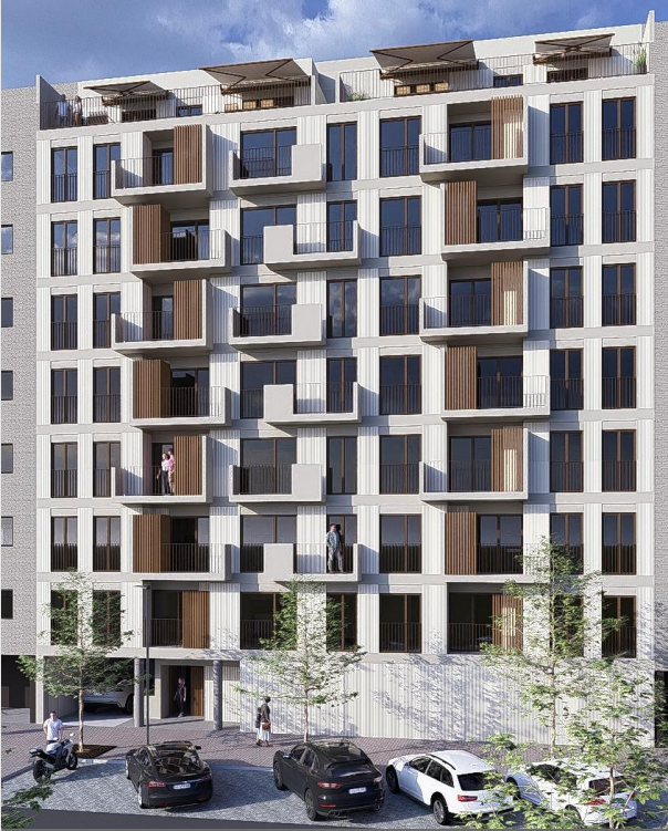
Edificio de 37 viviendas, piscina, garaje y trasteros – A.25.a.3 VALDECARROS
